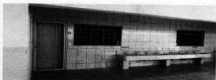
Fotos Demonstração de Instalação
